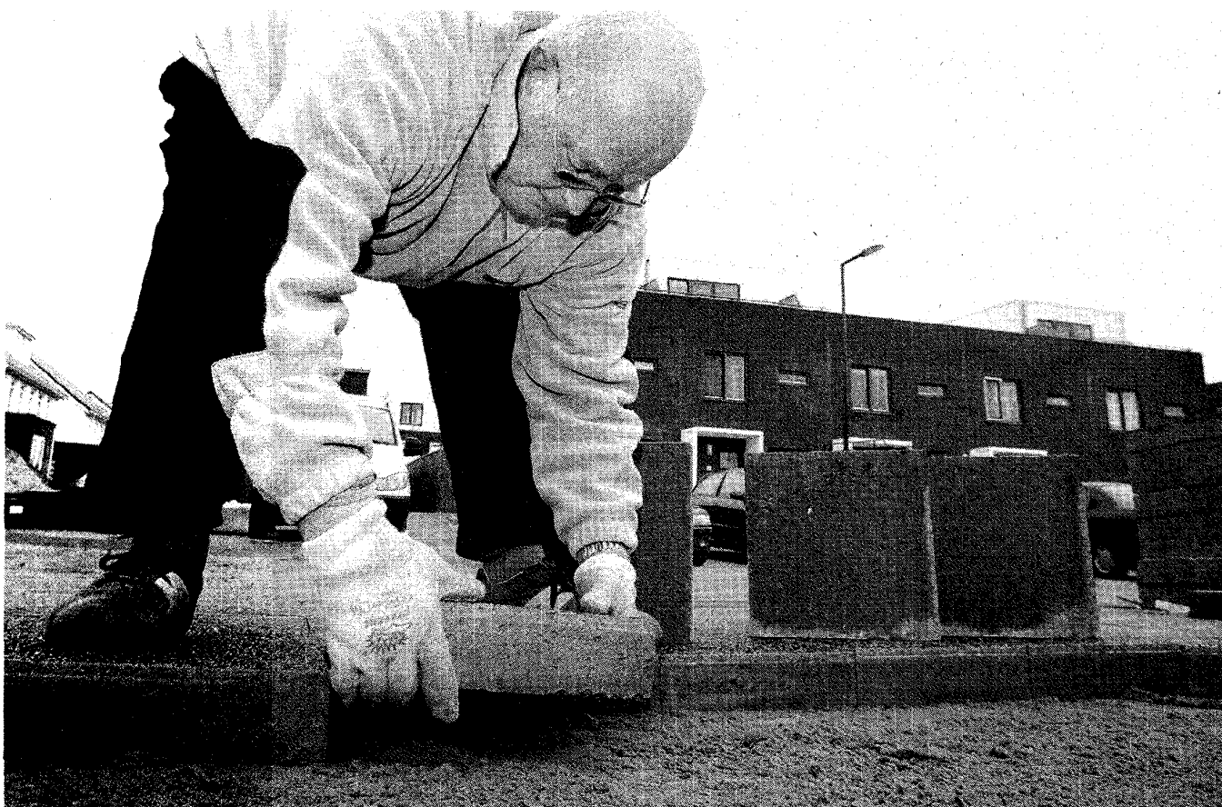
Een zestigplusser is als bestrater bezig in een Rotterdamse nieuwbouwwijk.
